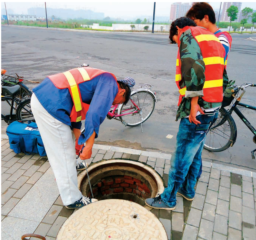
施工人员进行地下管线普查监理工作
