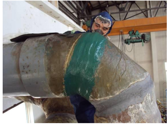
氢气管道弯头焊缝渗漏（UPVC）
