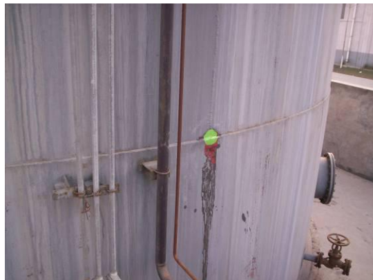
三氯乙烯罐体焊缝渗漏
