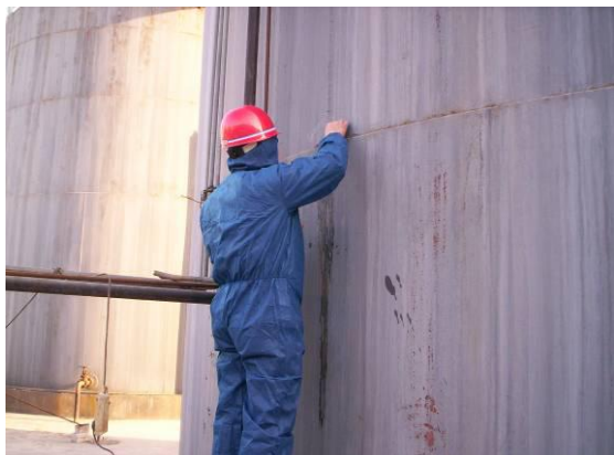
三氯乙烯罐体焊缝渗漏
