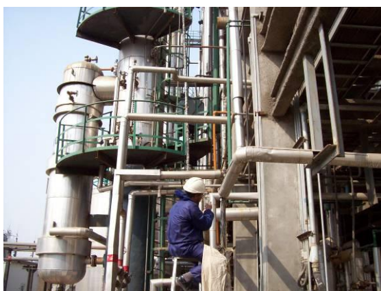
20%氢氧化钠管路焊缝裂纹、砂眼渗漏
