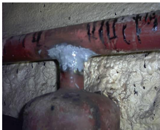
氨气管道渗漏治理
