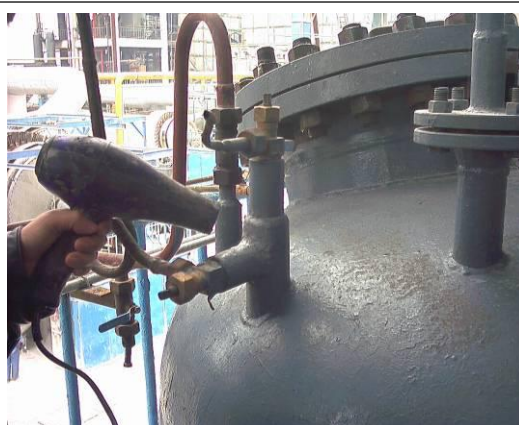
氯化氢氯乙烯反应釜管路砂眼渗漏
