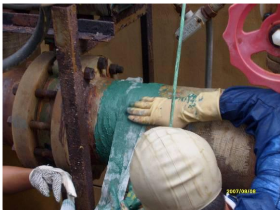
氯气管道渗漏（玻璃钢）
