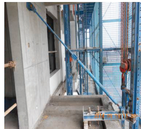
附板式导座安装实例
