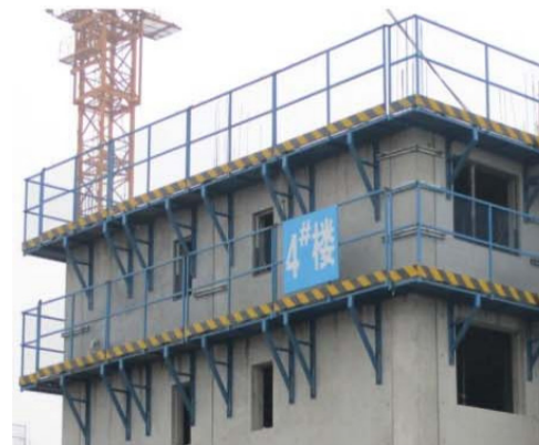
踏步板及防护网片安装
