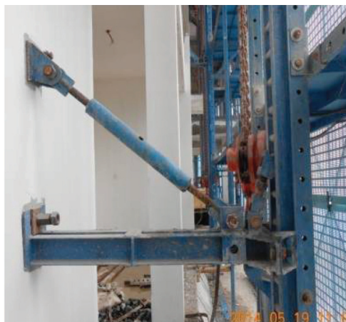
拉杆式导座安装实例
