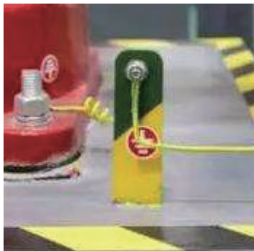
机具、设备外壳接地示意图
