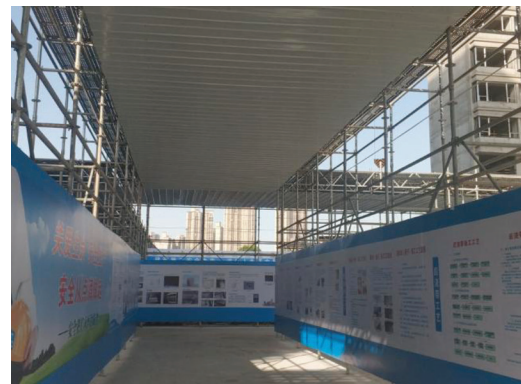
钢管扣件式防护通道
