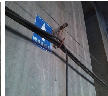
水平电缆挂线架
