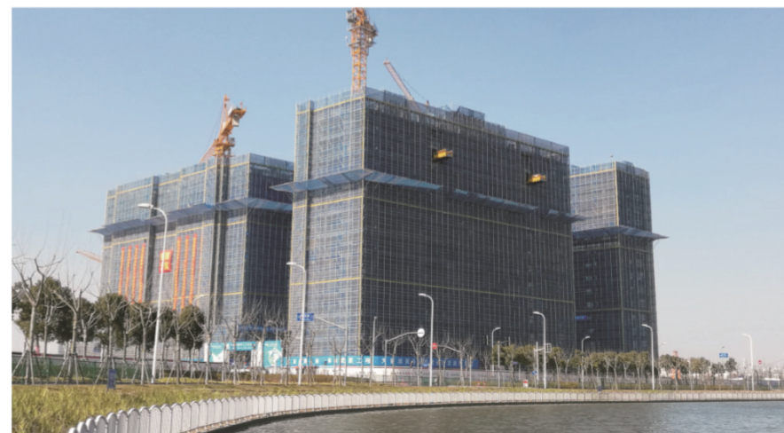
承插型盘扣式钢管脚手架外立面示意图
