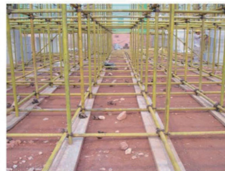
架体基础做法实物图（应设垫板）
