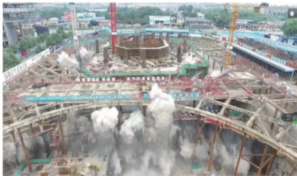
爆破拆除过程实景图
