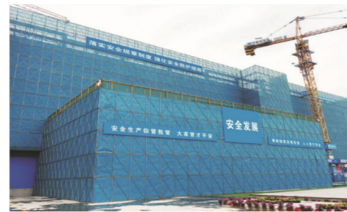
镀锌钢板网或冲孔钢板网代替安全网的外脚手架
