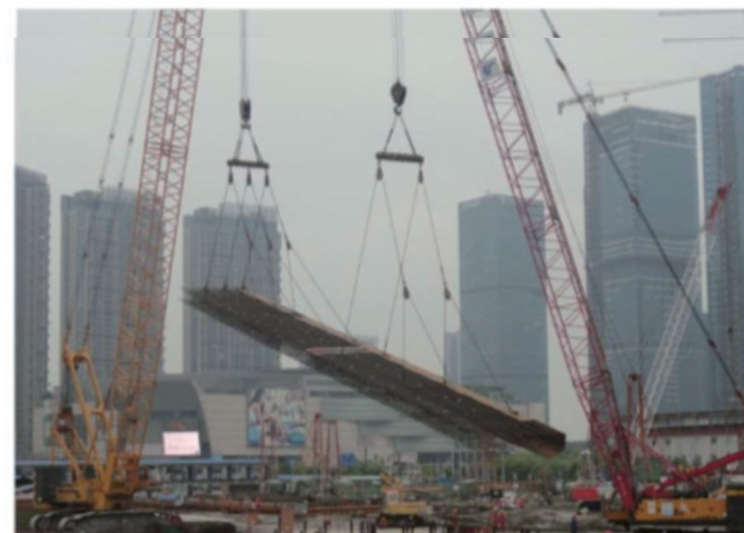
地连墙钢筋吊装
