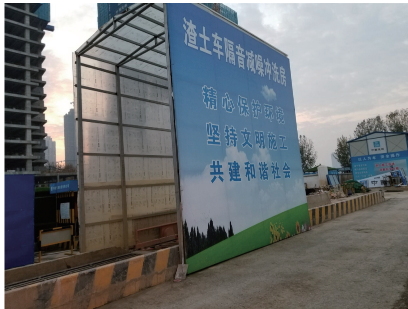
隔音减噪冲洗房（棚）效果图
