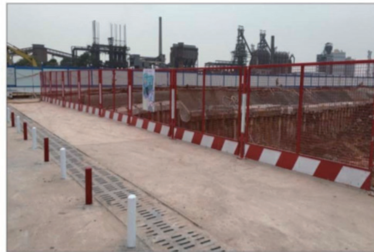
基坑周边设置排水沟及围挡
