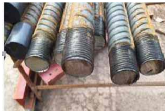
钢筋套筒端头切割平整
