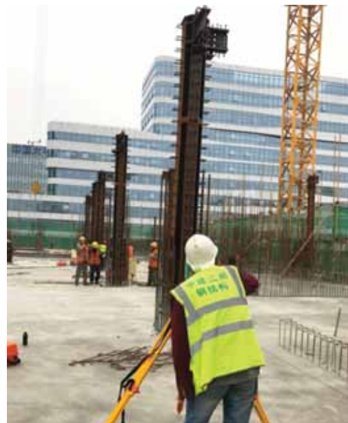
钢柱安装测量实例图
