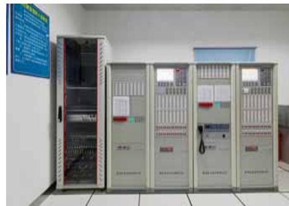
消防主机设备安装实例图
