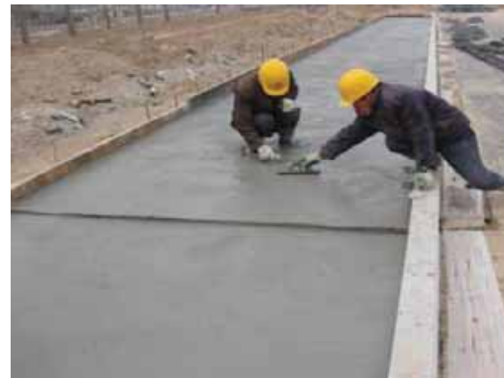
透水混凝土基层
