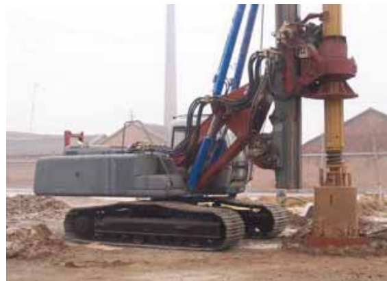
旋挖成孔灌注桩钻进成孔
