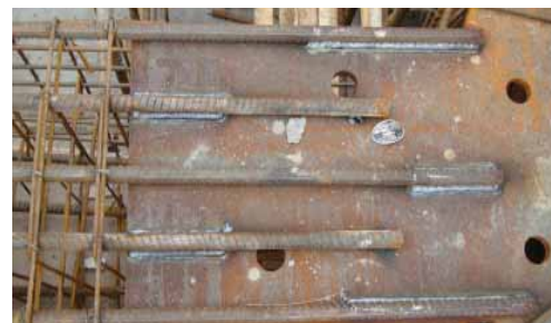
钢管混凝土柱与钢筋混凝土梁节点实例图
