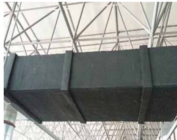
通风管道橡塑保温实例图
