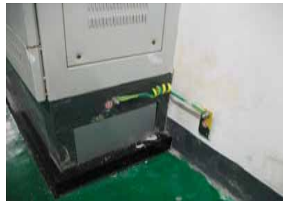
基础槽钢接地实例图
