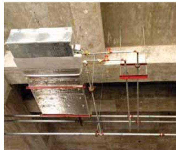
风机盘管接管实例图
