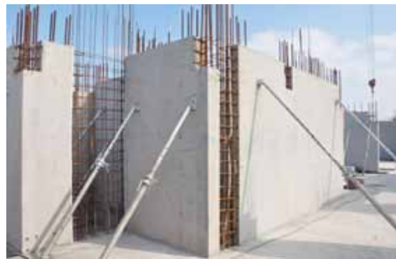
后浇段钢筋安装
