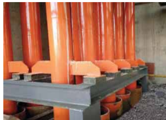
空调水竖向管道安装实例图
