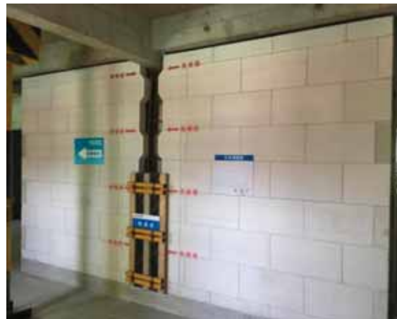
墙体表面整洁、胶缝横平竖直，厚薄均匀
