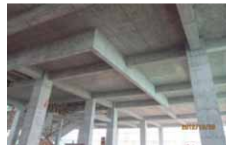
梁板结构成型效果
