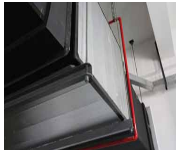
消声器独立支吊架设置实例图
