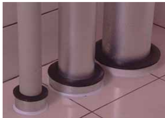
管道套管安装实例图
