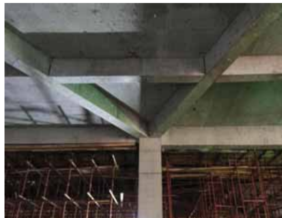
地下室梁柱节点混凝土成品
