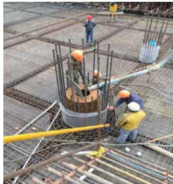
钢管内混凝土顶部浇筑实例图
