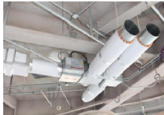
VAV 末端设备安装实例图
