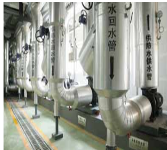
机房采暖水泵及管道安装
