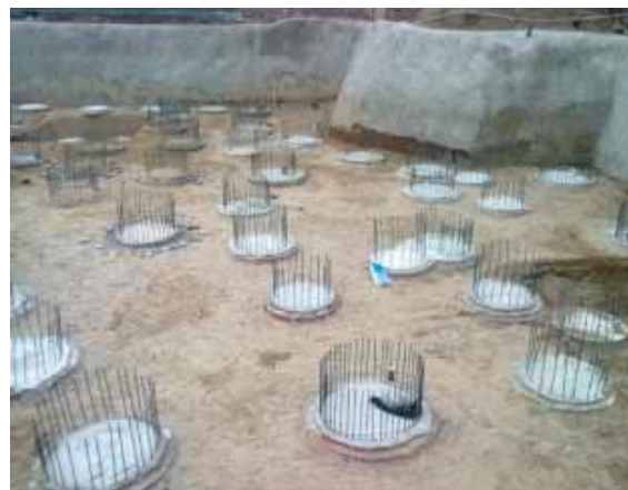
人工挖孔桩破桩桩头成品
