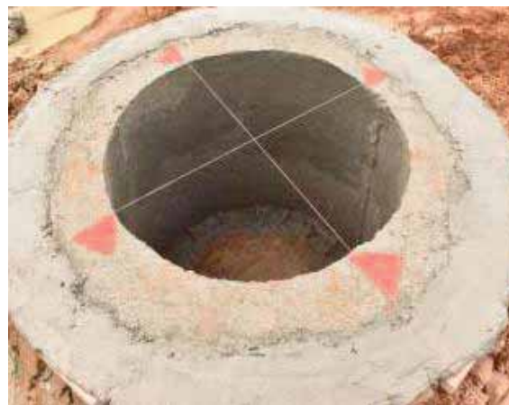
人工挖孔桩钢筋混凝土护筒及定位
