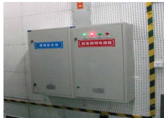
配电箱安装实例图
