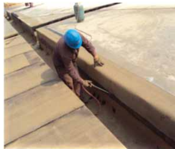
地下室防水卷材铺贴—热熔封边
