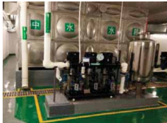
中水管道标识实例图
