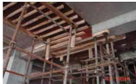
模板拆除保留后浇带支撑
