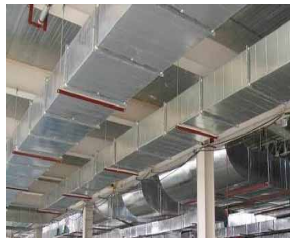
共板法兰风管安装实例图
