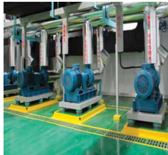
水泵安装实例图
