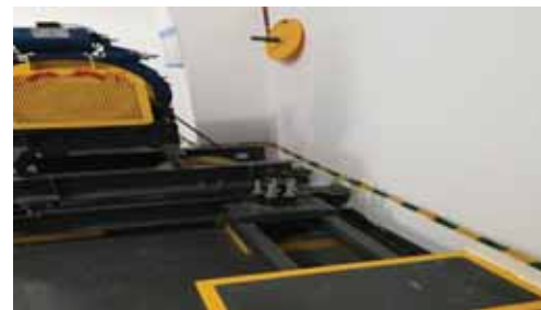
设备机房内接地干线敷设实例图
