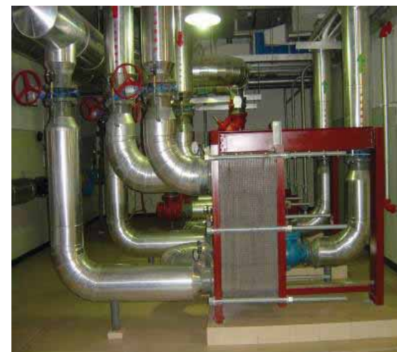
换热设备安装实例图
