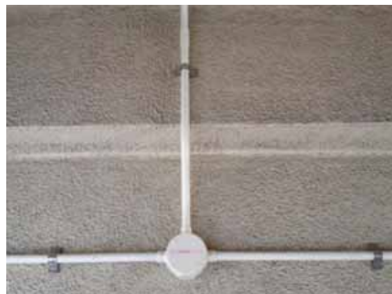
明配消防线管安装实例图
