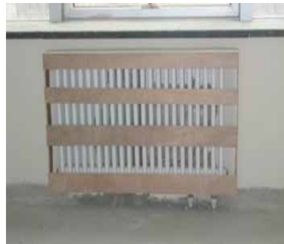
散热器成品保护实例图
