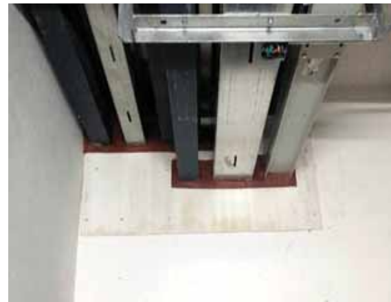
消防线槽穿墙防火封堵实例图
