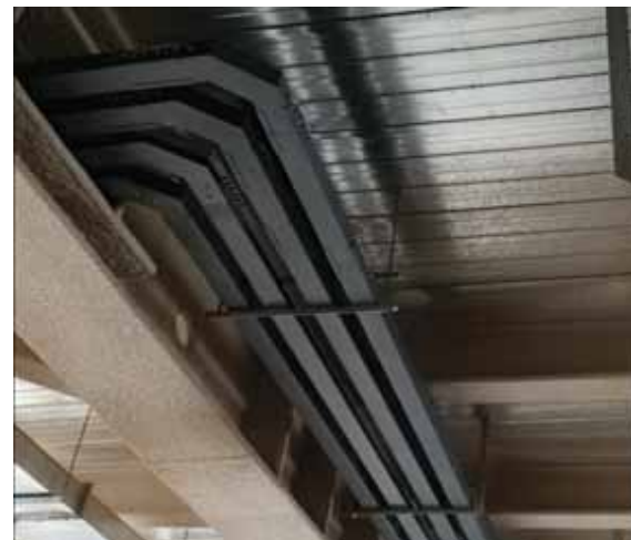
消防金属线槽安装实例图
