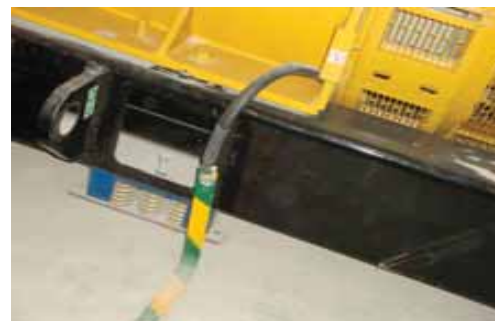
发电机接地安装实例图
