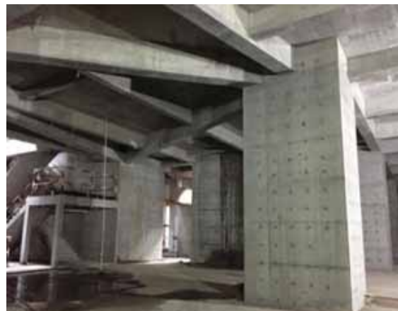
地下室剪力墙节点混凝土成品
