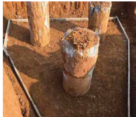
冲击钻成孔灌注桩清桩成品
