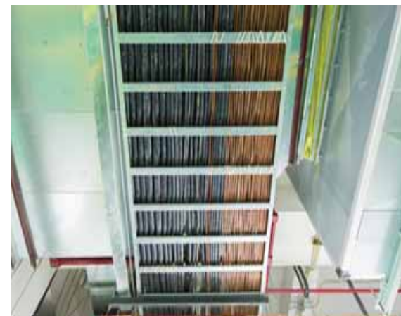
电缆梯架安装实例图
