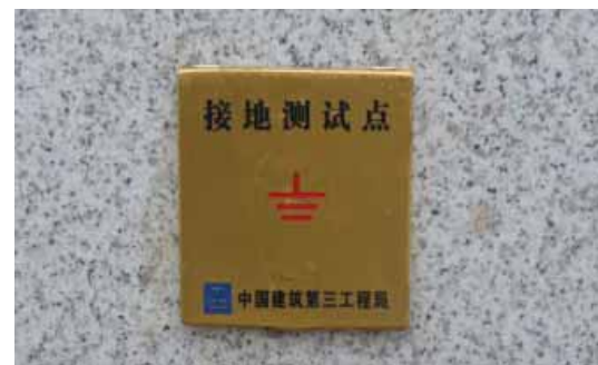
接地测试点实例图
