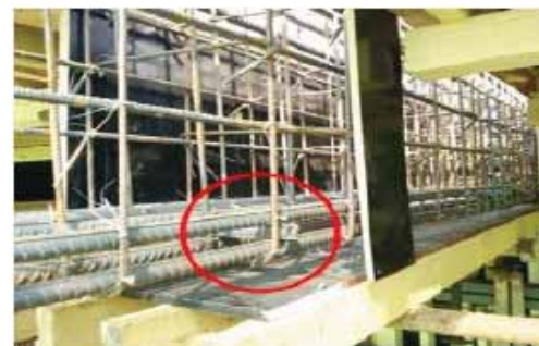
梁底二排钢筋分隔到位
