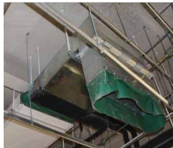
风机盘管风管接管实例图
