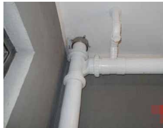
U-PVC 排水管安装实例图
