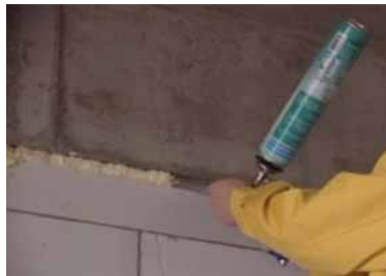
顶部采用发泡剂填充
