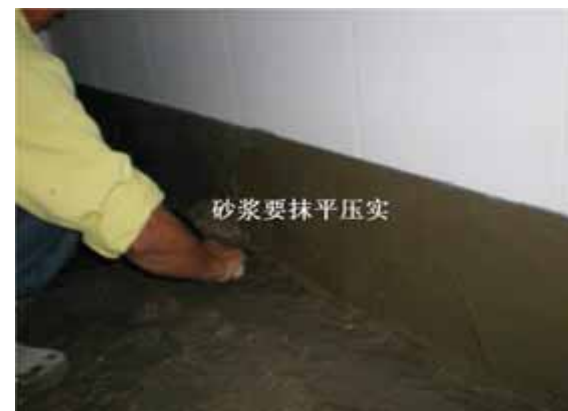
水泥砂浆防水层施工
