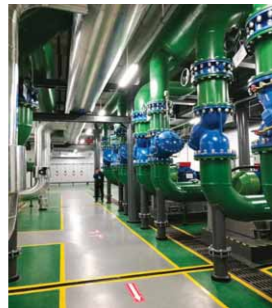
机房空调水管道安装实例图
