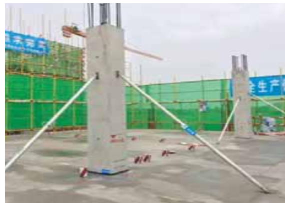
预制柱定位加固
