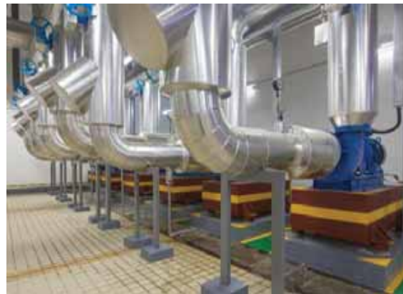
卧式水泵房安装实例图
