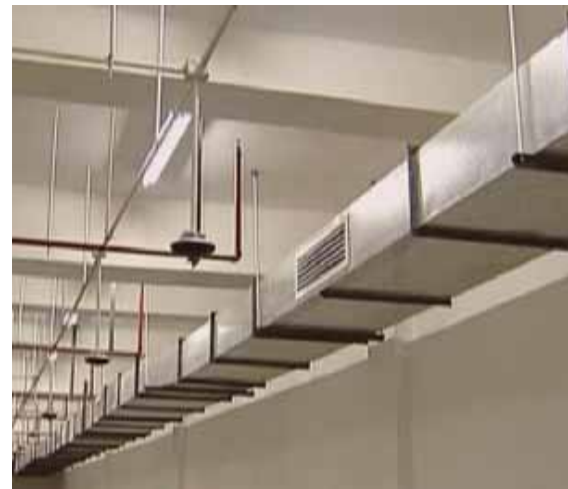
角钢法兰风管安装实例图
