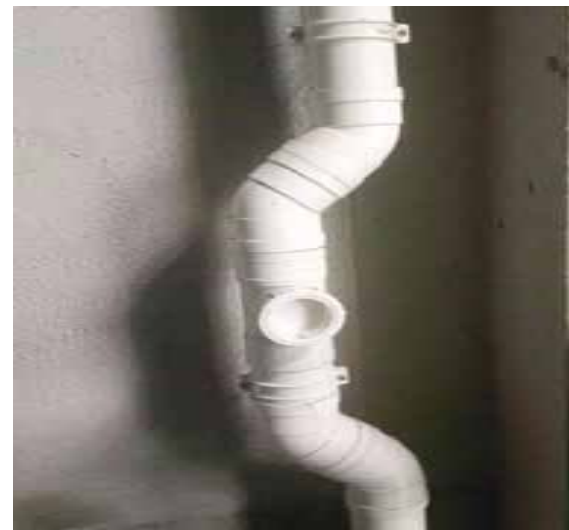
雨水管道消能装置实例图
