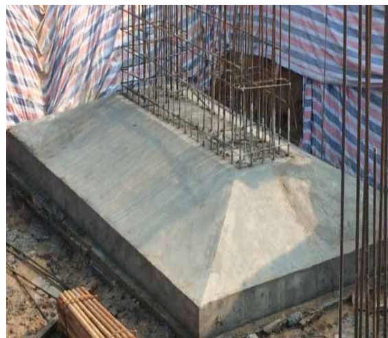
独立基础混凝土成品
