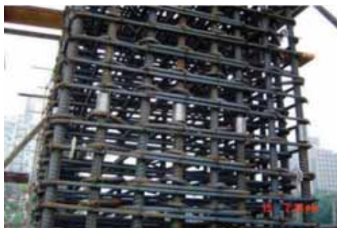
柱筋绑扎规范，避开套筒连接范围
