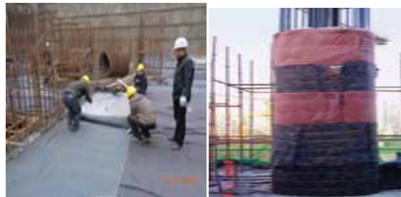
混凝土覆盖养护
