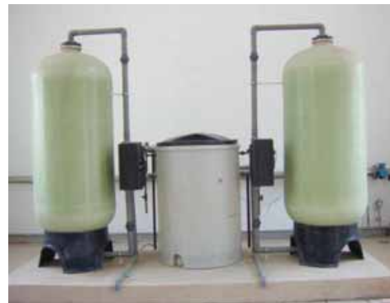
软水设备安装实例图
