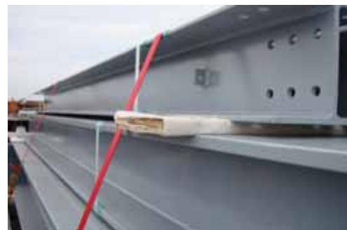
钢结构成品保护实例图
