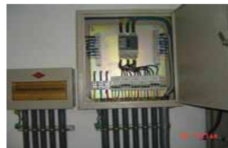
导管出电箱实例图
