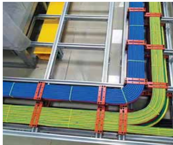
弱电线在静电地板下敷设实例图
