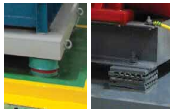
水泵减震安装实例图
