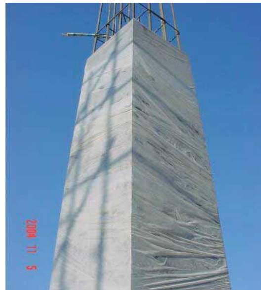
柱子包裹塑料薄膜养护
