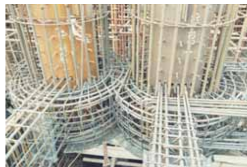
钢管混凝土柱与钢筋混凝土双环梁节点实例图
