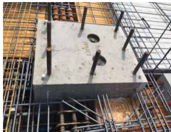
预制柱钢筋定位
