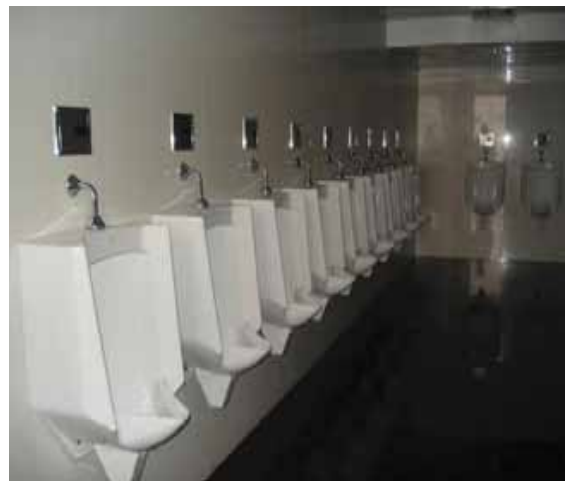
感应式冲洗阀壁挂式小便器实例图
