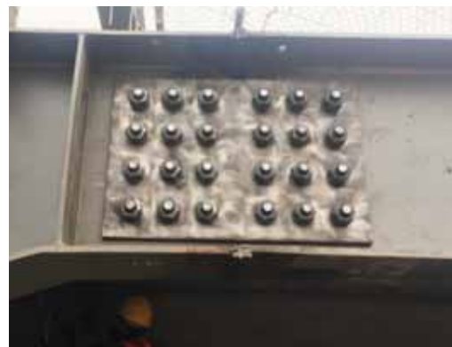
高强螺栓施工质量实例图
