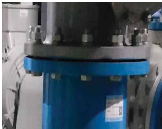
阀门固定螺栓实例图
