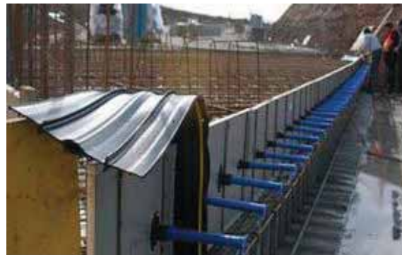
止水带施工示意图
