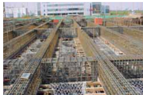
结构梁绑扎成型
