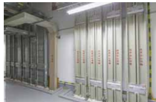
竖井内接地干线敷设实例图
