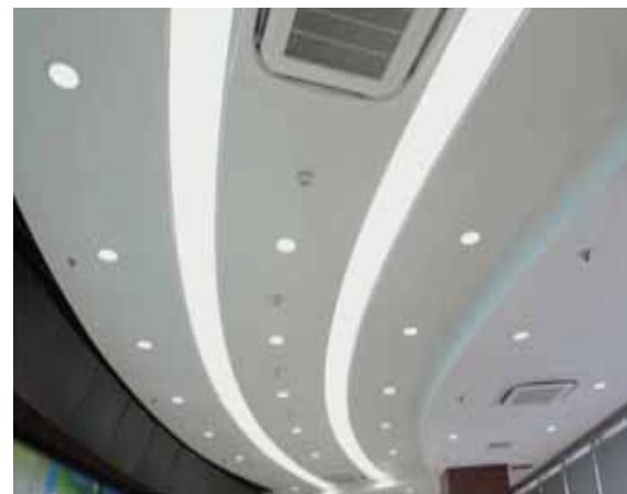
烟感天花吊顶安装实例图
