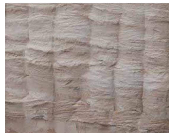
高压旋喷桩成品
