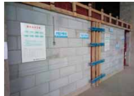
圈梁与构造柱模板加固
