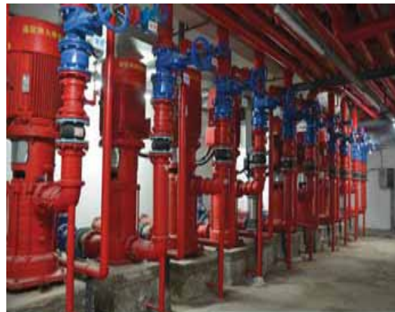
立式水泵房安装实例图
