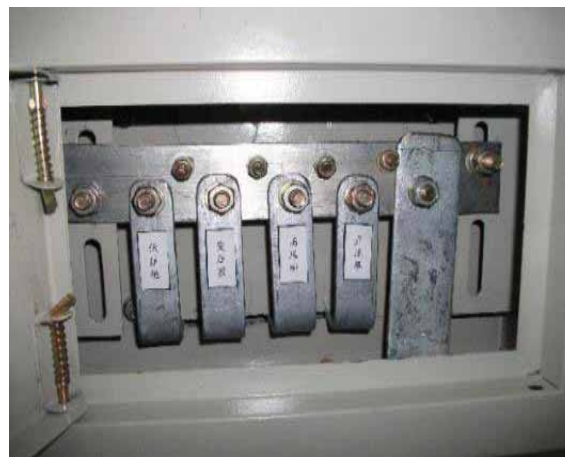
等电位端子连接实例图
