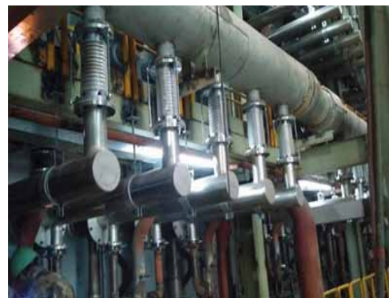
采暖管道补偿器安装实例图
