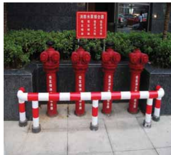
消防水泵接合器安装实例图
