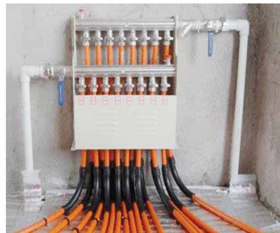
罩箱式分、集水器安装实例图
