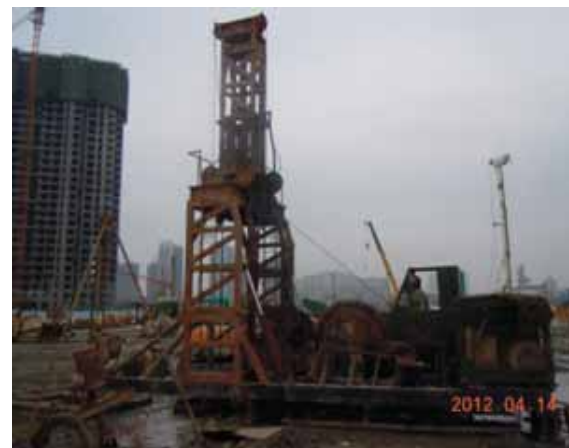
冲击钻成孔灌注桩钻进成孔
