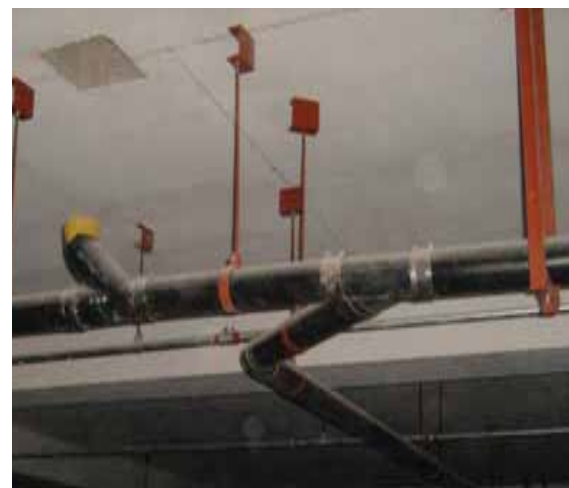
铸铁管支架安装实例图
