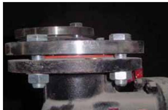
法兰垫安装实例图
