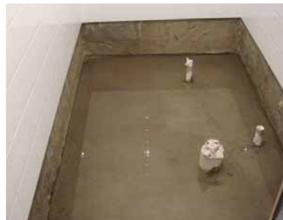
防水隔离层蓄水试验
