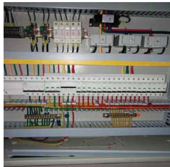
配电箱接线实例图
