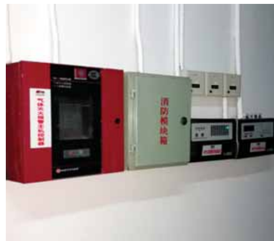
现场弱电控制设备安装实例图
