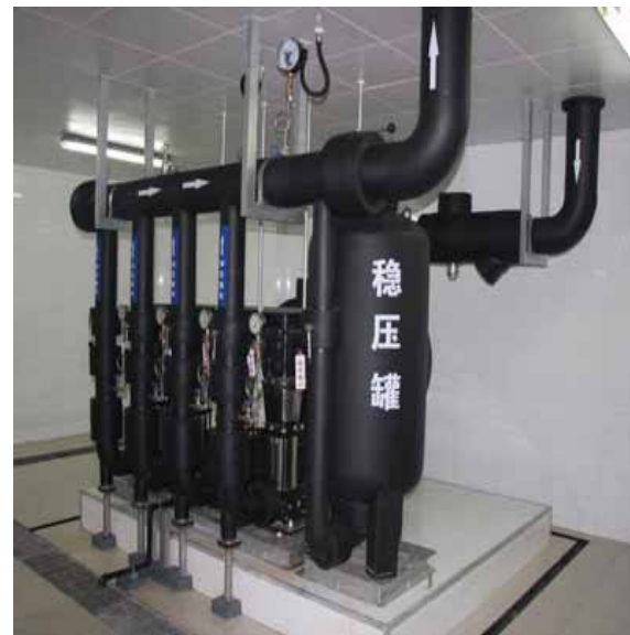
空调水管道系统保温实例图
