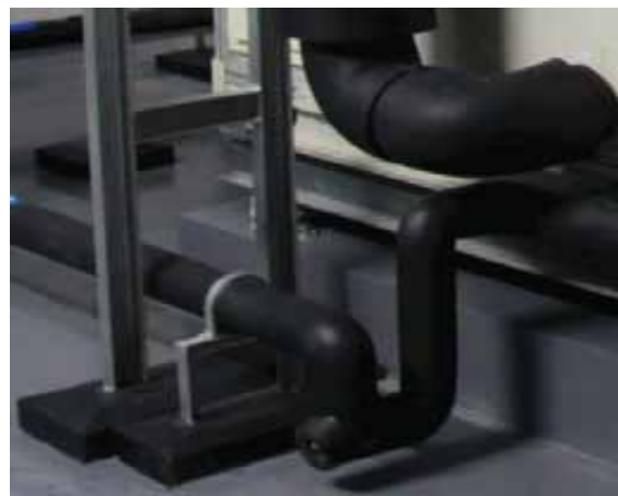
机组冷凝水管水封实例图
