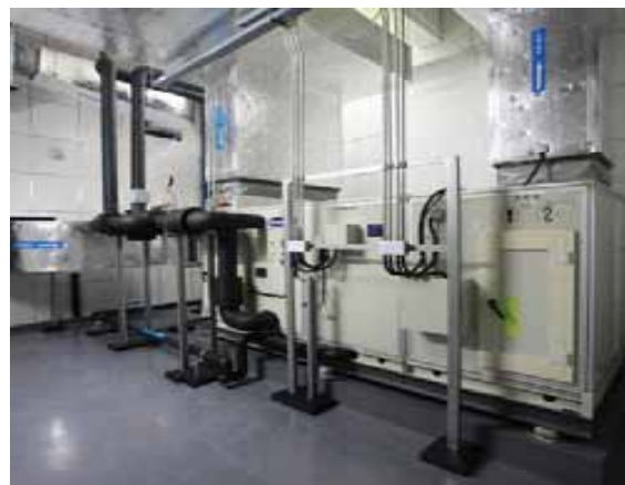
机组接管实例图
