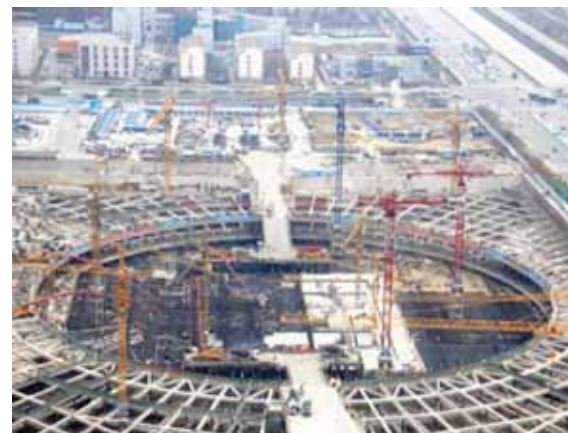
钢筋混凝土水平支撑（环撑）
