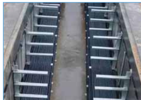
电缆沟电缆敷设实例图
