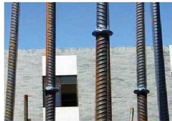
竖向结构钢筋电渣压力焊连接
