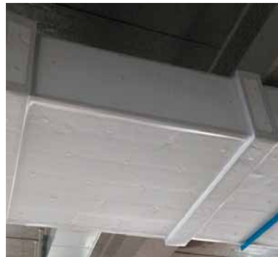
通风管道离心玻璃棉保温实例图
