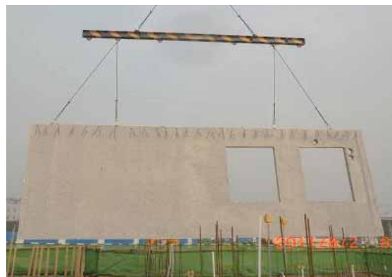
预制外墙板吊装
