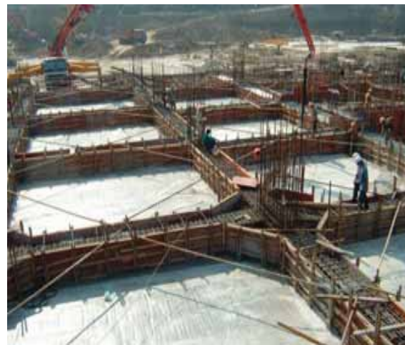
筏板基础混凝土浇筑
