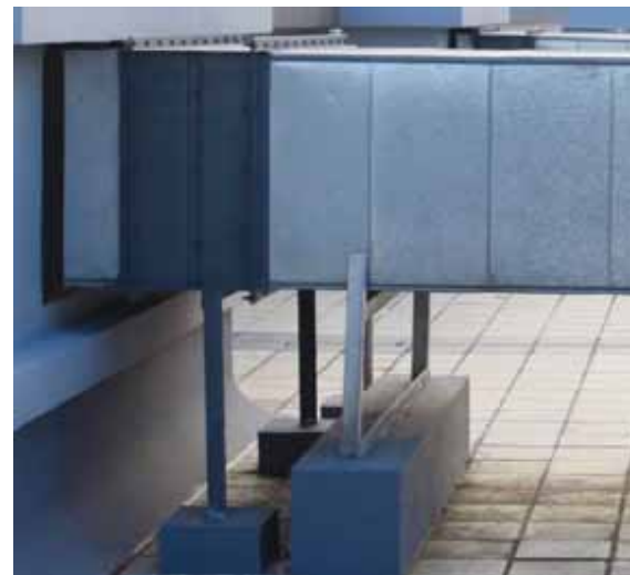
风阀独立支架设置实例图
