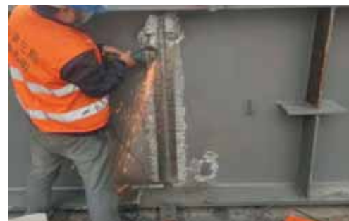
焊缝外观及处理实例图
