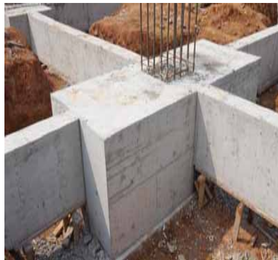
独立基础与地梁连接节点
