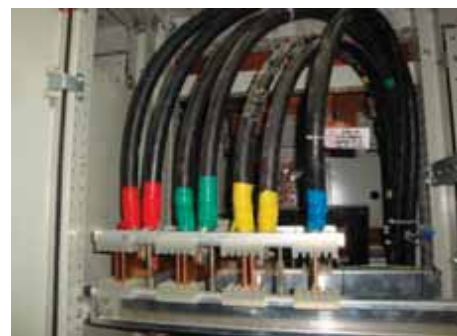
电缆头安装实例图
