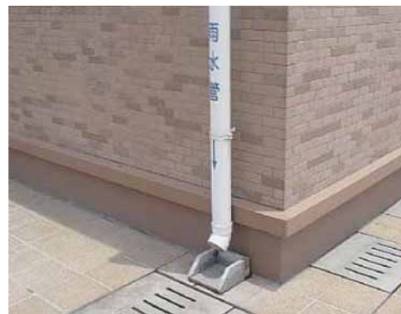
雨落管安装实例图
