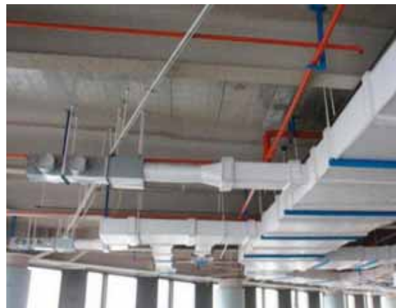
VAV 末端设备安装实例图
