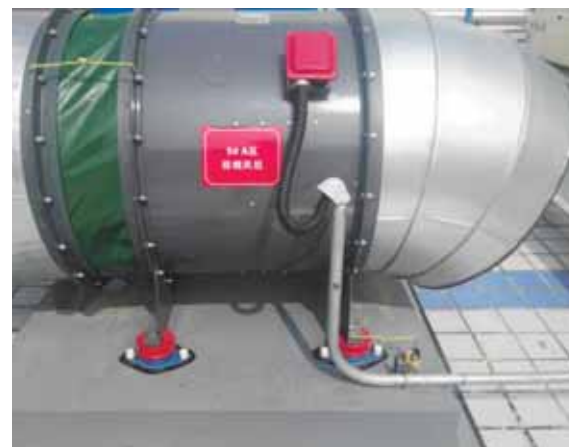
风机落地安装实例图
