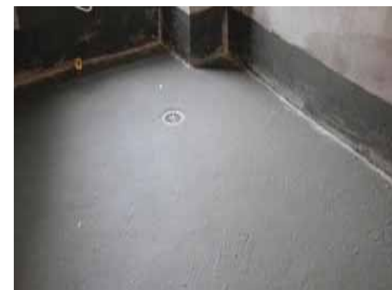
水泥砂浆防水层施工完成面
