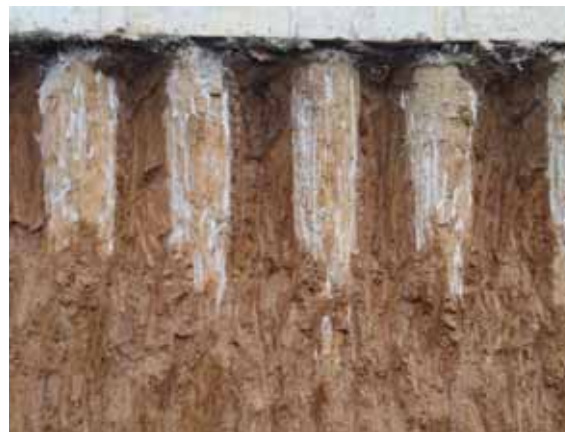
旋挖成孔灌注桩清桩成品
