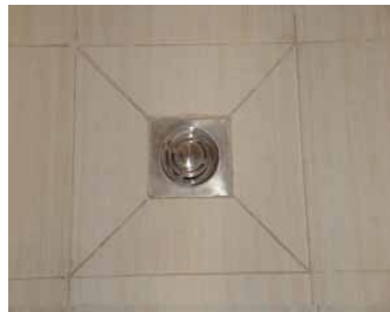
地漏安装实例图
