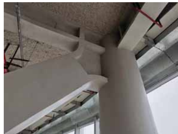
防火涂料施工实例图
