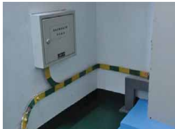
等电位端子箱安装实例图
