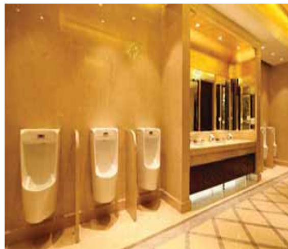
感应式冲洗阀壁挂式小便器实例图
