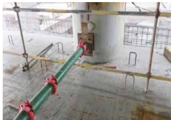
钢管内混凝土底部浇筑实例图
