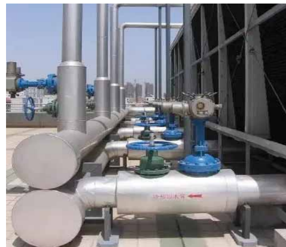
冷却塔管道接驳安装实例
