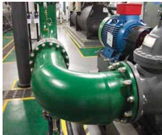
管道防腐实例图
