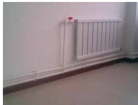
钢制板型散热器安装实例图
