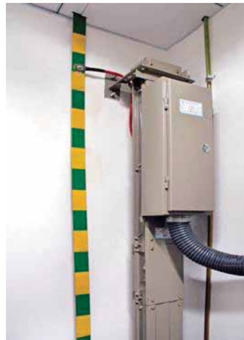
母线接地实例图
