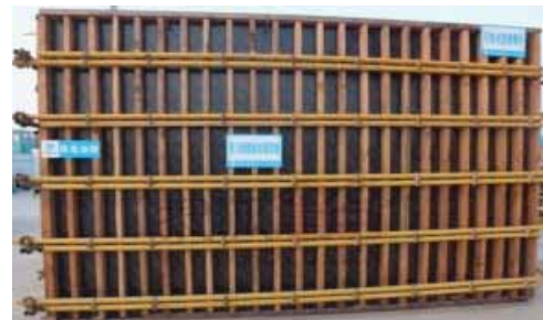
剪力墙加固成型
