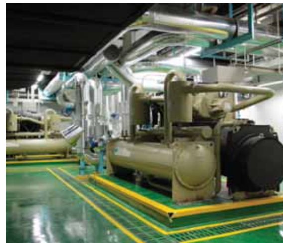
制冷机组安装实例图
