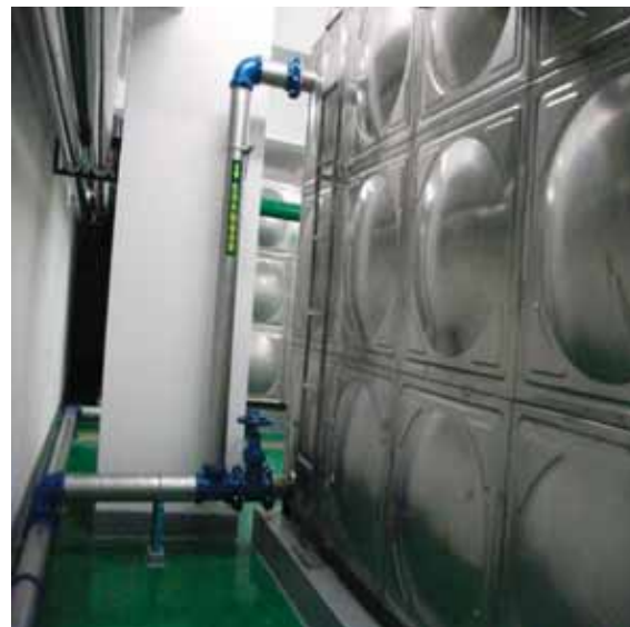
溢流管、泄水管安装实例
