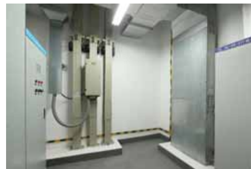
封闭母线安装实例图
