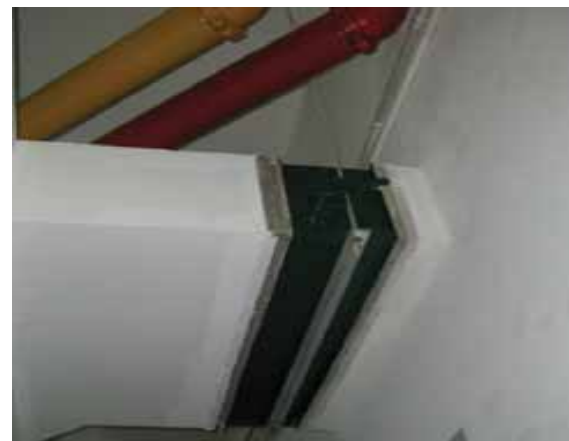
防火阀距墙安装实例图
