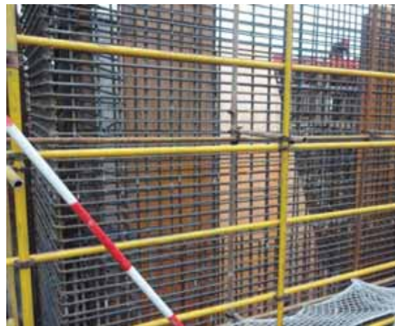
地下室墙柱钢筋绑扎
