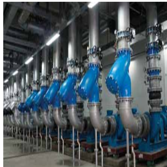
空调水管道安装实例图
