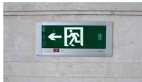
疏散指示灯安装实例图
