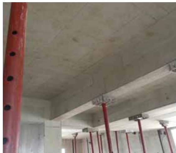
后浇段连接成型效果
