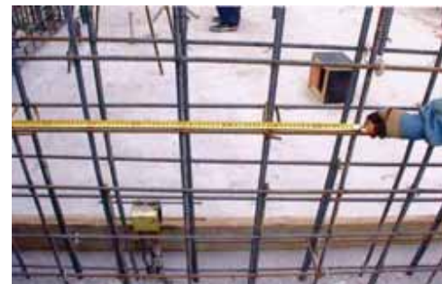
剪力墙水平、竖向筋绑扎
