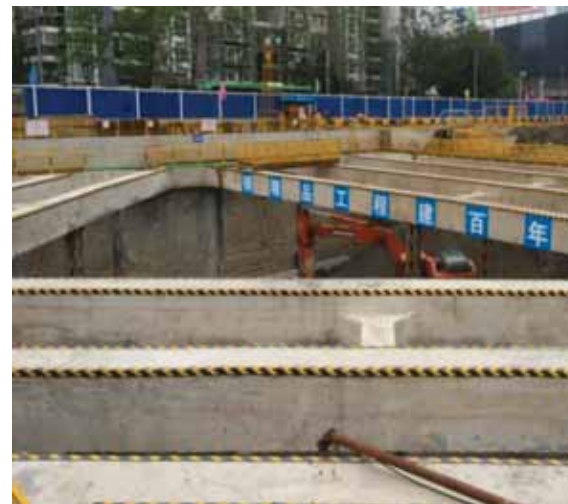
钢筋混凝土水平支撑（角撑）
