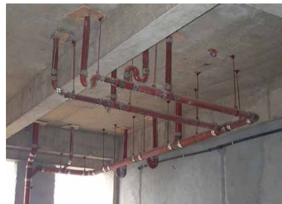
铸铁排水管安装实例图
