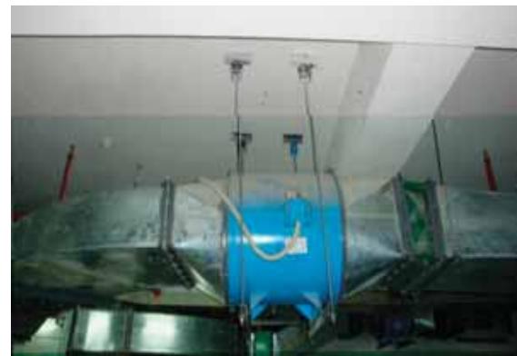
风机悬挂吊装实例图
