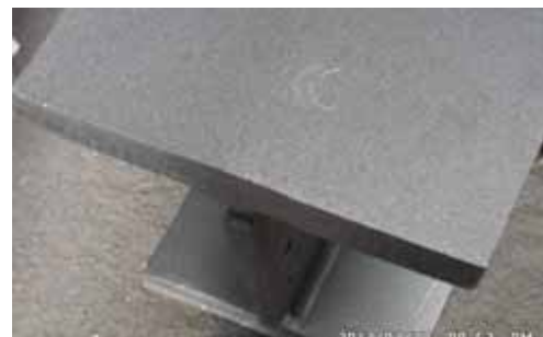
构件除锈质量实例图
