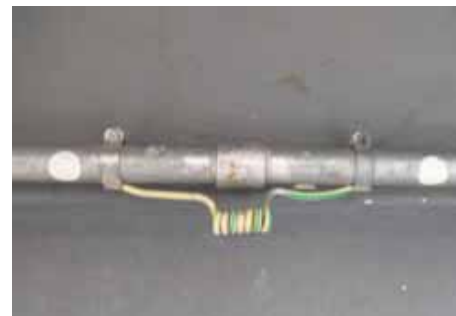
焊接钢管连接实例图
