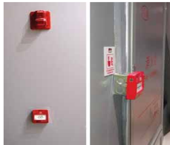
消防点型设备安装实例图
