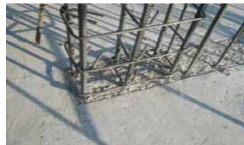
剪力墙施工缝
